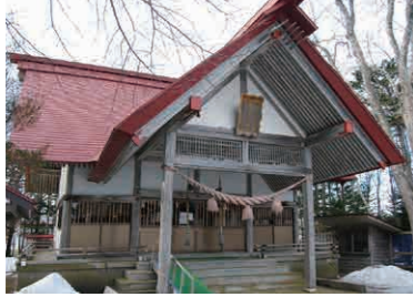
(上)「金刀比羅神社」(根室市)と(下)「標津神社」(標津町)。標津神社は今も屏風と同じ場所にあるため、神社を起点に標津を歩けば当時のまちを思い描くことができる。
